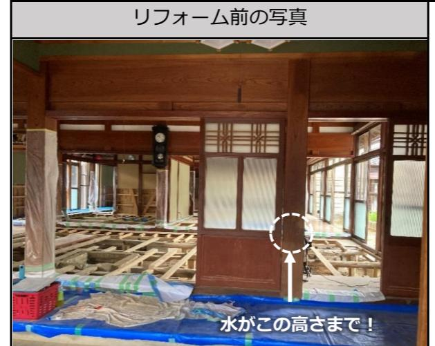
大雨で1階部分は水に浸かるという大きな被害に。柱に残る浸水の痕跡。
